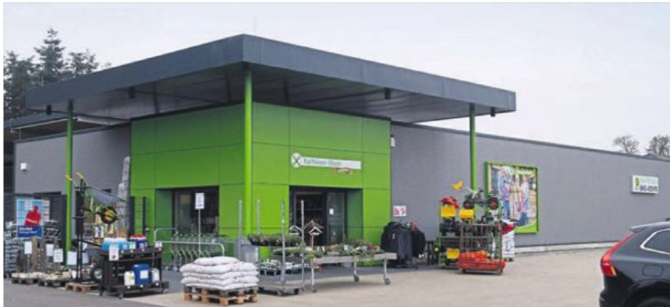
Einen hohen Wiedererkennungswert hat das große Vordach der Raiffeisen in Felsen. Der Hallenkomplex erstreckt sich über eine Nutzfläche von insgesamt 792 Quadratmeter.
