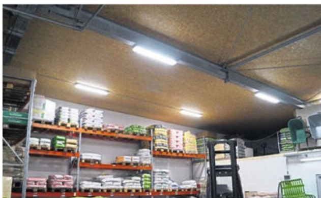
Die Dachkonstruktion wurde innen mit OSB-Platten verkleidet.
